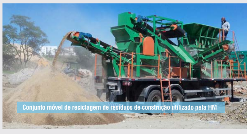
Conjunto móvel de reciclagem de resíduos de construção utilizado pela HM
